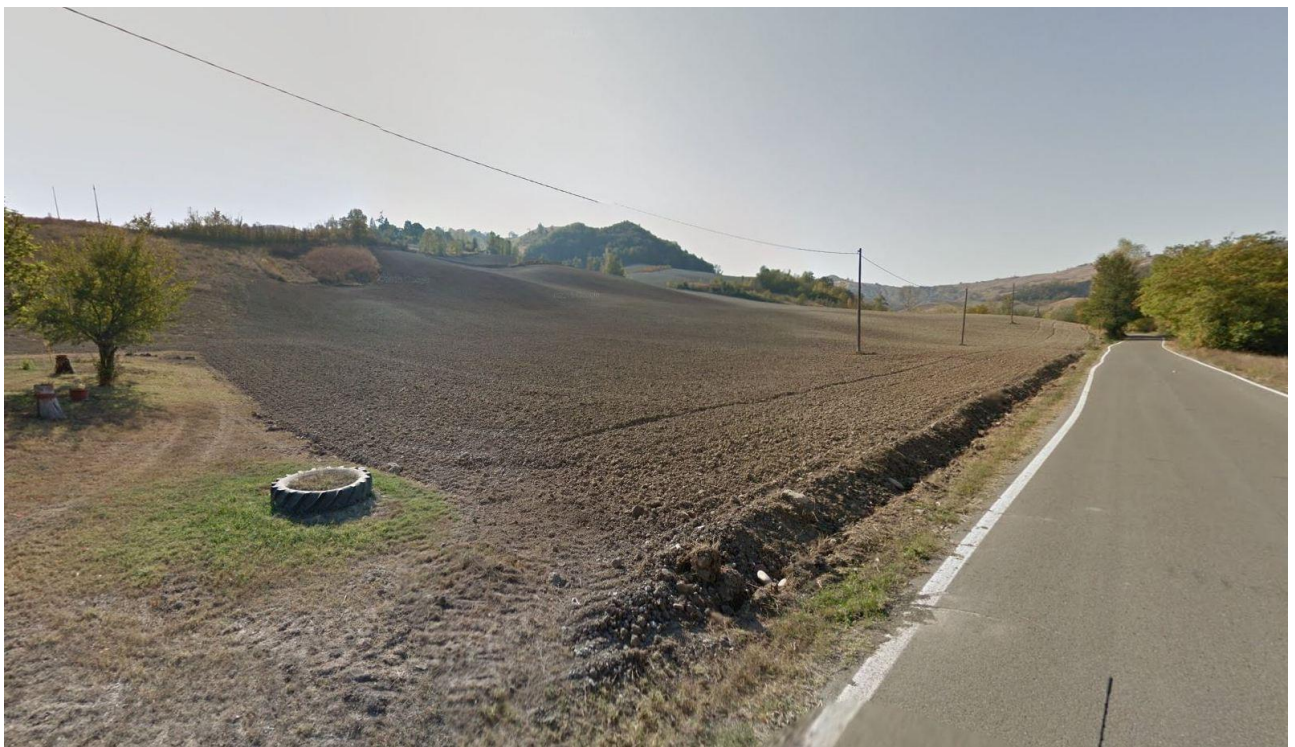
Vista dell'area di studio da via Pianazza, nord
